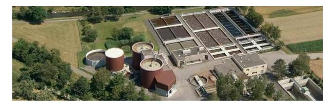
Die Kläranlage ist während 365 Tagen und 24h pro Tag in Betrieb. Nach dem Zulaufhebewerk wird das Abwasser mechanisch (Grobrechen, Feinrechen, Sandfang; Vorklärung) gereinigt. In der folgenden biologischen Stufe finden die Denitrifikation und die Nitrifikation statt. Der Phosphor wird durch eine Füllung mit Eisensalzen eliminiert. In der anschliessenden Nachklärung findet die Sedimentation des Belebtschlammes statt. Das gereinigte Abwasser wird nach der Nachklärung in die Glatt eingeleitet.
